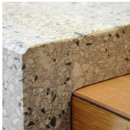
schodiště - terrazzové obkladové stupně, broušené hladké, s protiskluzným pískovaným páskem, sražené hrany; šedý cement, vícebarevné kamenivo
