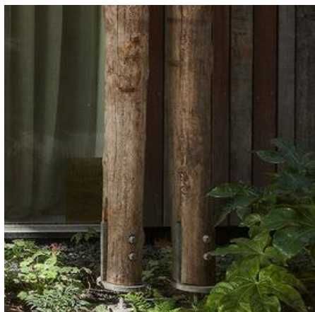
loupané kmeny, kotveny do ocelové patky, opatřeny olejovou lazurou se světle šedým pigmentem
