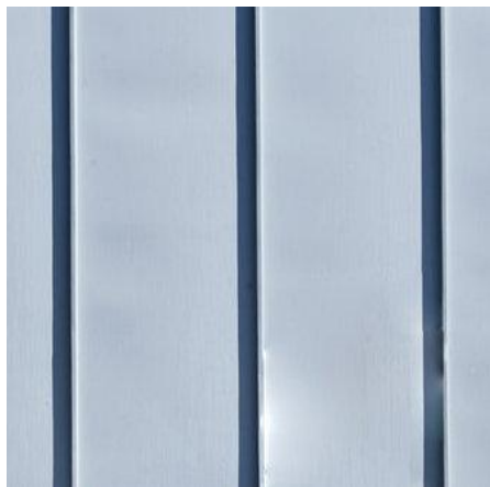
střešní a fasádní krytina vikýř - přírodní titanzinek s dvojitou (střecha) a úhlovou (fasáda) stojatou drážkou, bez povrchové úpravy
