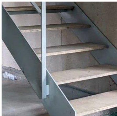
schodiště ocelové žárově zinkované, nátěr kovářskou grafitovou barvou; stupně masiv borovice, olejvosk
