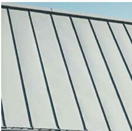
falcovaná střešní krytina - hliník s dvojitou stojatou drážkou, nástřik v odstínu světle šedé
